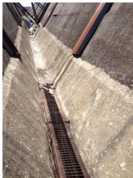
Imagem 03 – Grelha de captação
